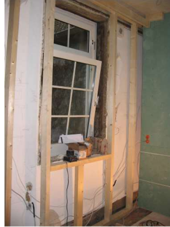
Holzständer an Boden und Decke befestigt
